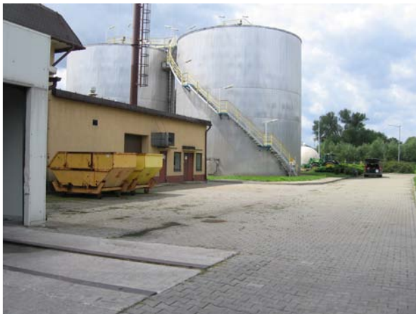
Zdjęcie 2 i 3. Budynek gospodarki gazowej i osadowej oraz zamknięte komory fermentacyjne.
