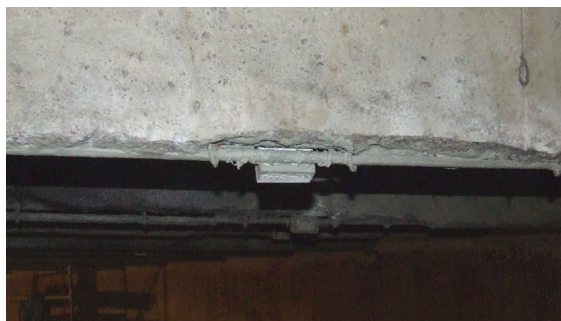
Fot. 6. Montaż protektorów na zbrojeniu - obiekt remontowany
