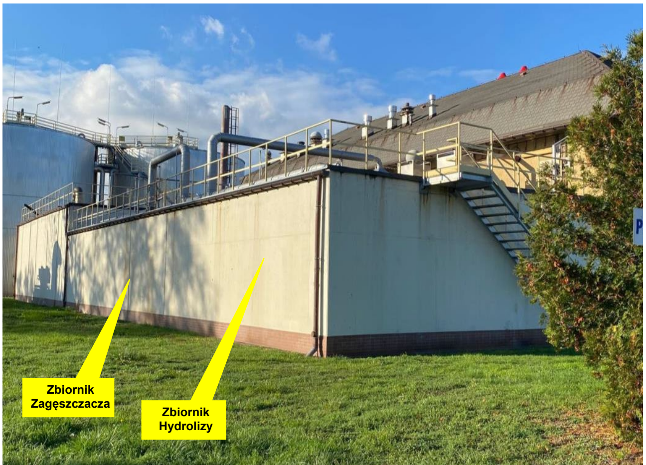
Fot. 1. Widok Zbiornika Hydrolizy i Zbiornika Zagęszczacza
